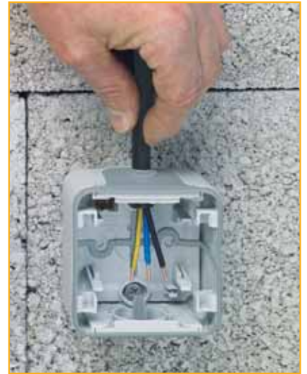
Η μεμβράνη εξασφαλίζει IP 55 προστασία στην εγκατάσταση
