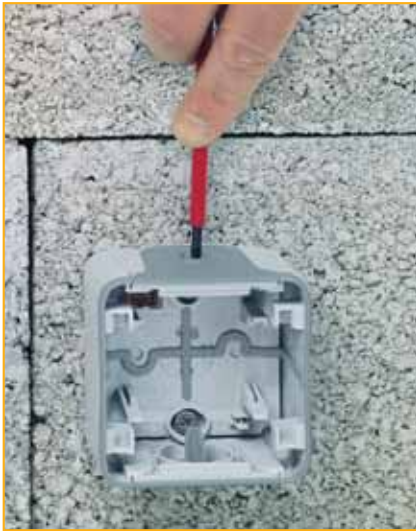
Τρυπήστε τη μεμβράνη με κατασβίδι
